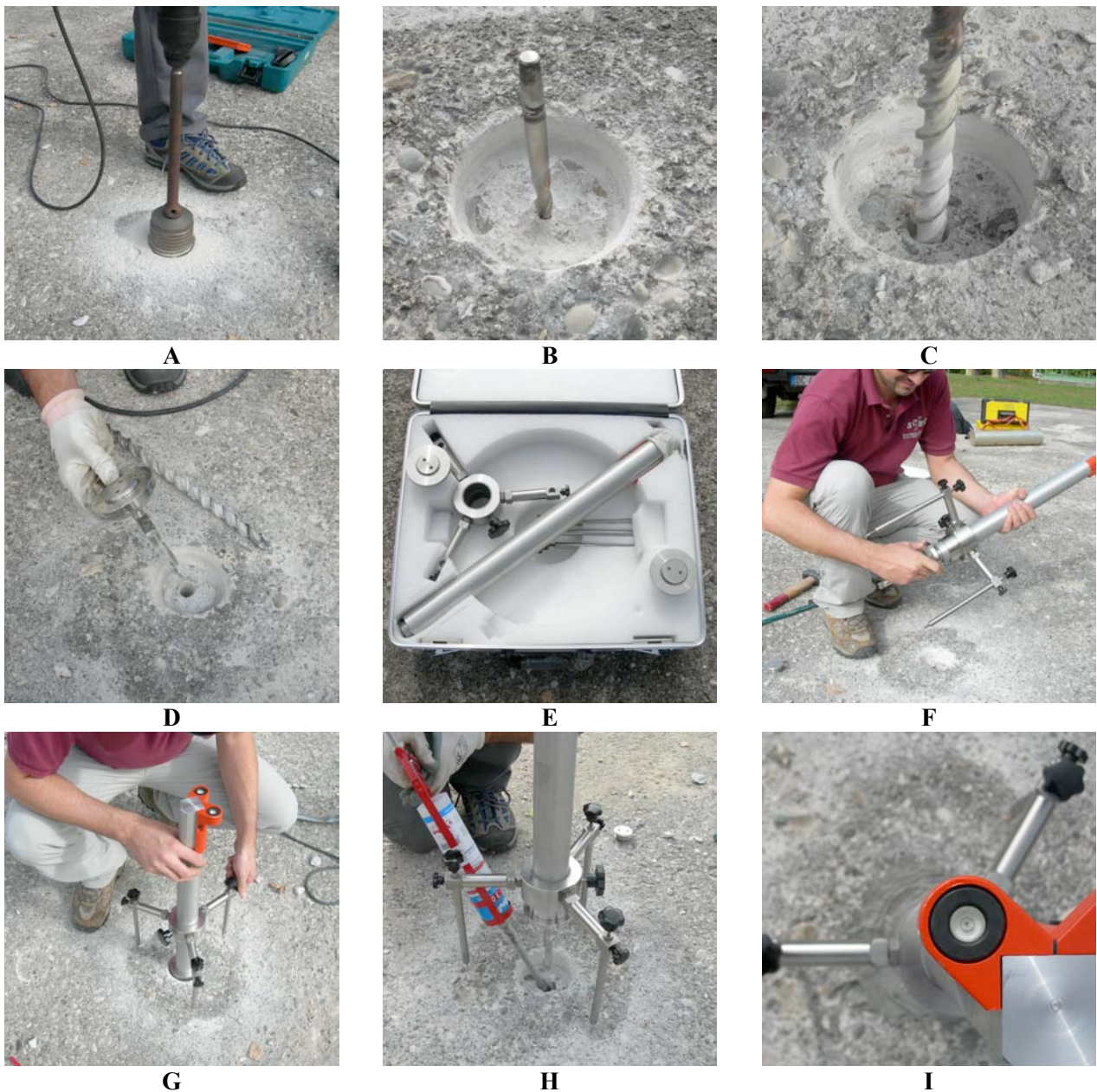
Figura 9. Fasi di realizzazione di un caposaldo tipo max-mount . A: realizzazione della tazza di alloggiamento del caposaldo tramite martello perforatore. B: pulizia della tazza. C: realizzazione del foro, di almeno 25 mm di diametro, per l'alloggiamento del chiodo del caposaldo. D: prova di inserimento del caposaldo. E: valigetta e leveling-device smontato. F: montaggio del leveling-device e fissaggio del caposaldo alla base di questo. G: livellazione del caposaldo, prima tramite regolazione macro-metrica, e quindi di precisione tramite regolazione micrometrica. H: sollevamento del caposaldo ed inserimento della resina bi-componente nel foro e nella tazza. I: abbassamento del leveling-device e del caposaldo con inserimento di questo nell'alloggio in cui è stata colata la resina, o il cemento. Queste foto, prese a documentazione delle varie fasi di realizzazione di un max-mount , sono relative ad un sito su piattaforma in cemento armato in provincia di Treviso.
